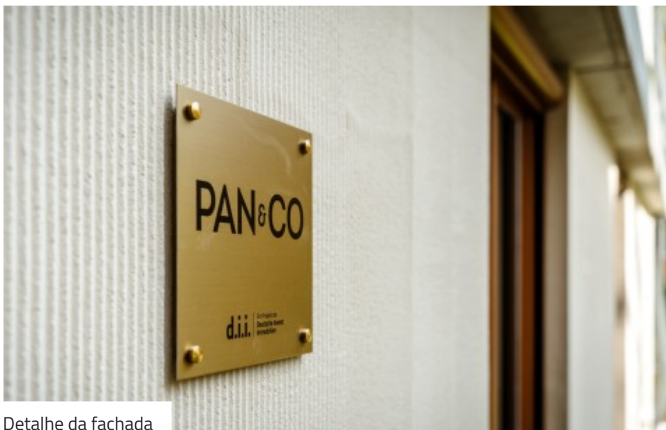
Detalhe da fachada
