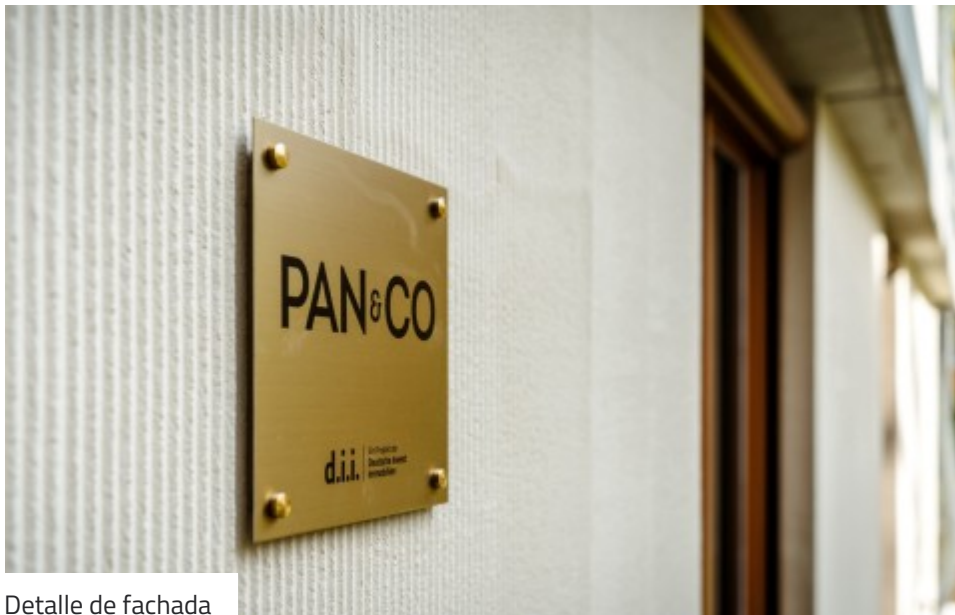
Detalle de fachada
