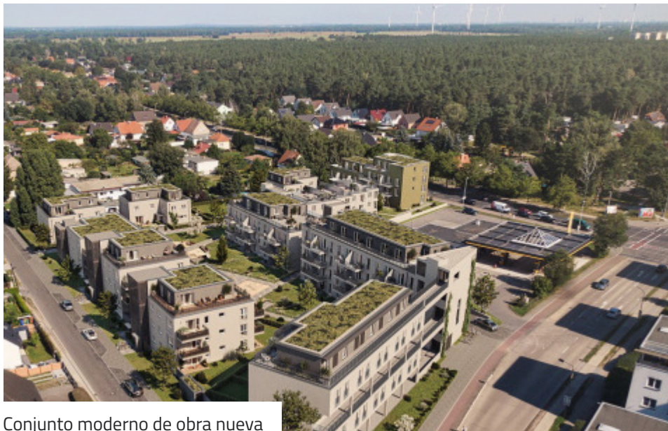
Conjunto moderno de obra nueva
